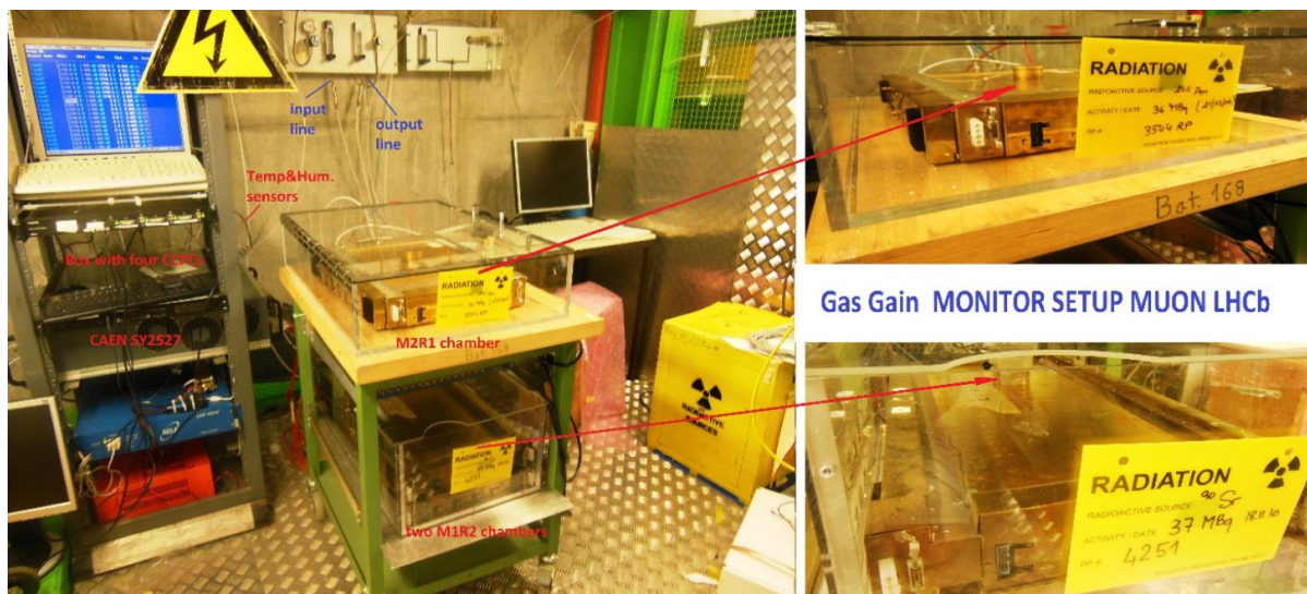
Рисунок 7. Установка для контроля качества газовой смеси с радиоактивными источниками.
