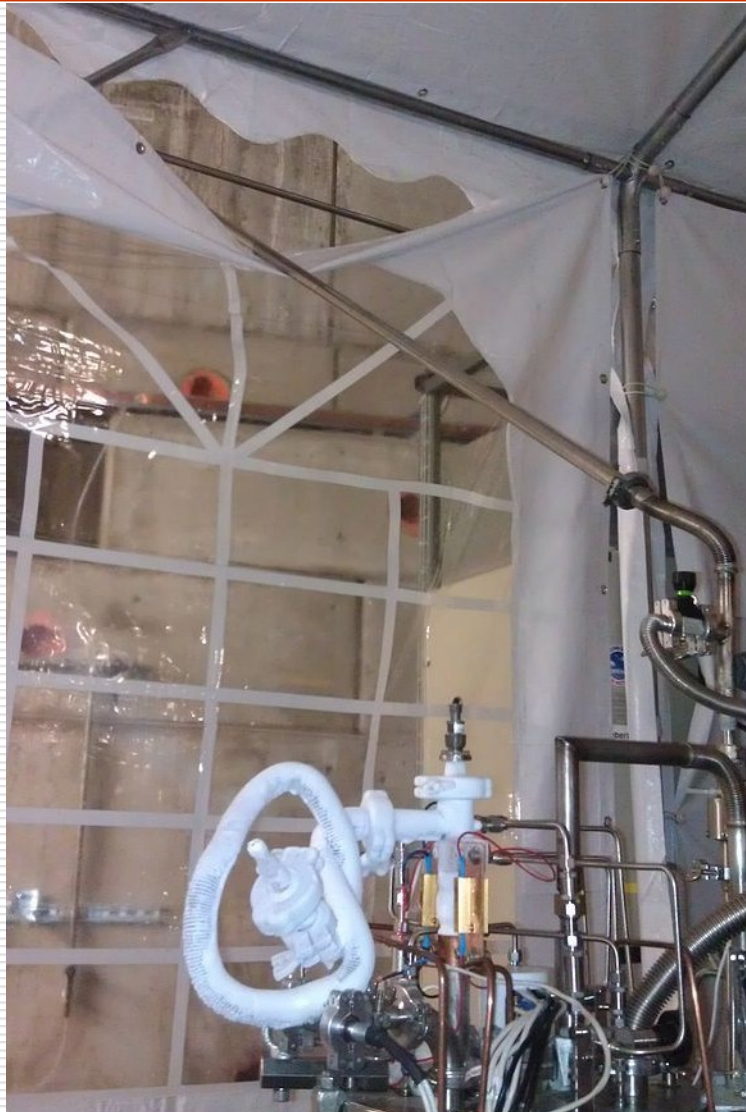
Линия автоматической подачи азота в CHUPS и криогенные преусилители
