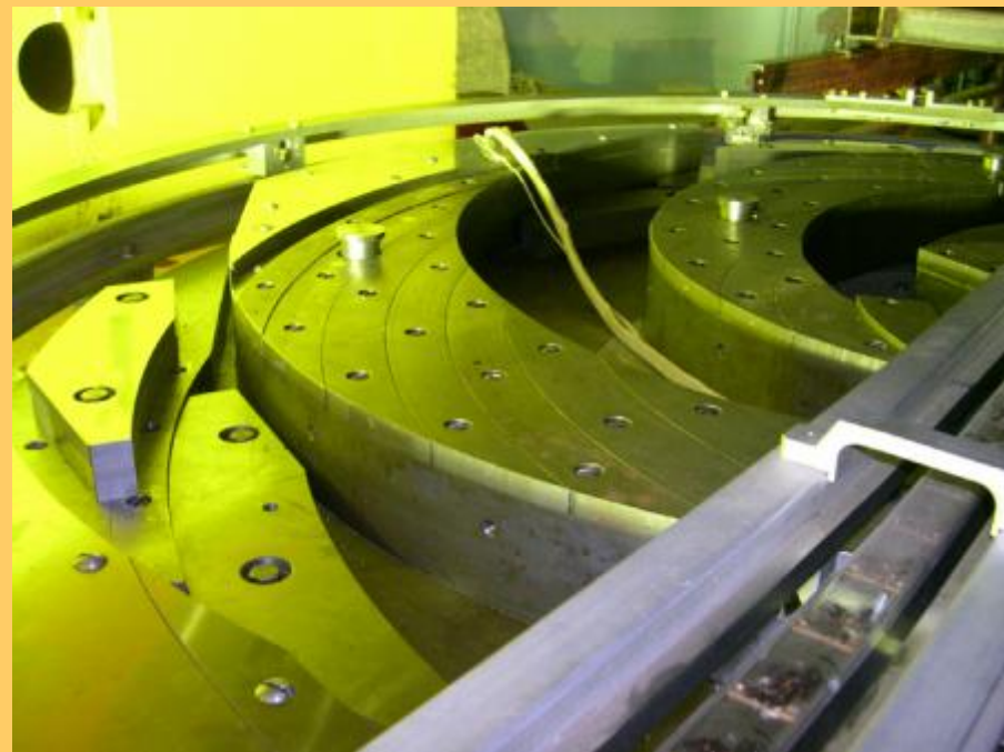
Монтаж новых шимм.
