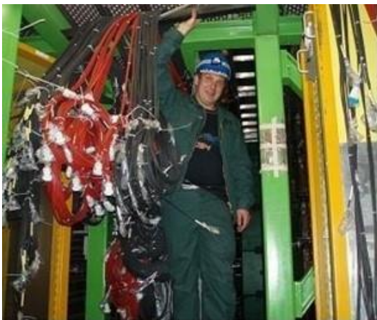
О.Е.Маев, монтаж мюонной системы LHCb
