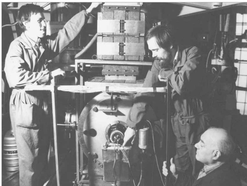
На установке вертикального канала для измерения асимметрии распада нейтрона.
